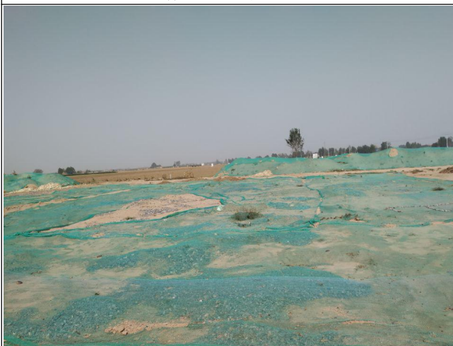
1 标 k1+900 临时堆土防护及覆盖
