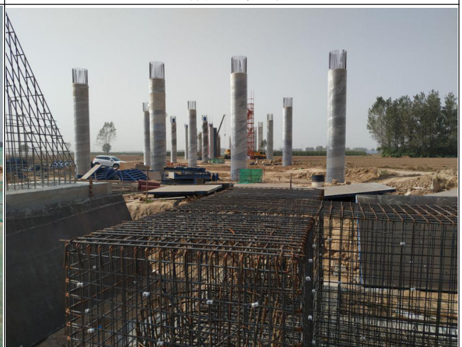
1 标跨铁路专用桥 k15+943
