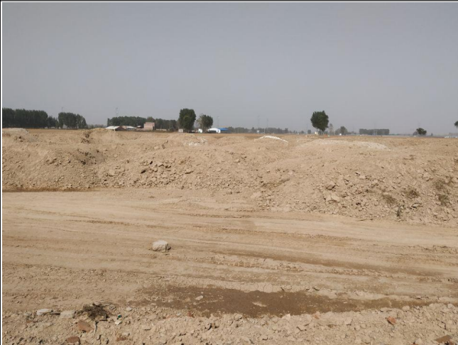
临时堆土裸露面未进行覆盖
