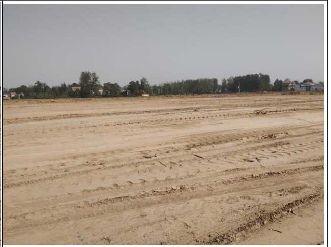
k12+900 扰动裸露面未进行覆盖
