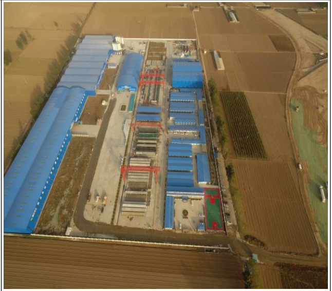
2 标项目部、梁场、拌合站
