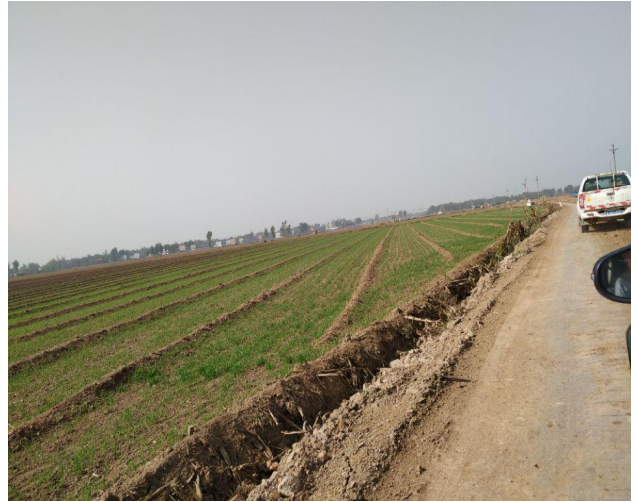
说明：施工便道排水沟淤积现象。
